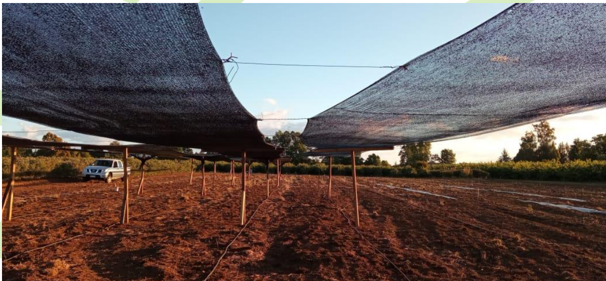
Imagen 6. Estructuras de soporte de mallas Rachel para simular condiciones de sombra en los ensayos del proyecto.
